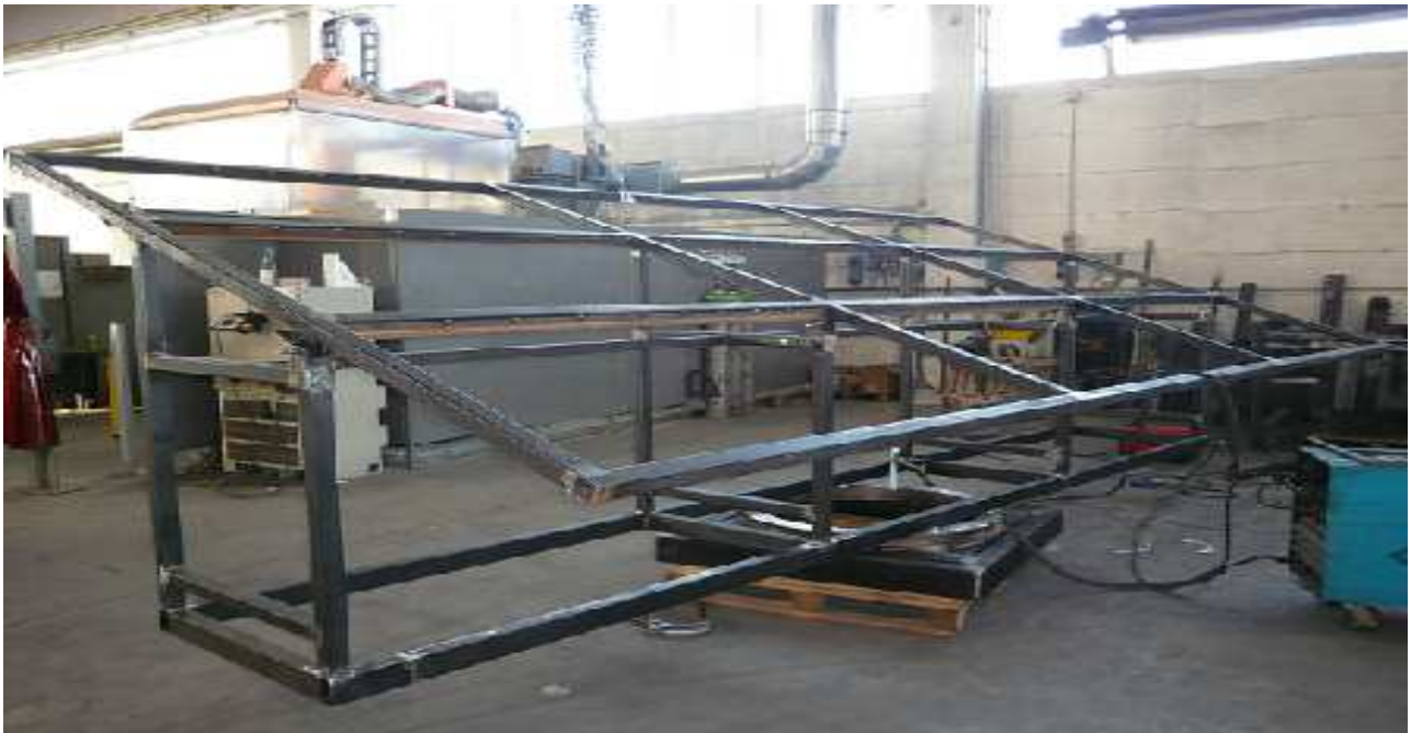
Figura 5.6.2 Struttura in costruzione presso la ditta Mastec (VR)
