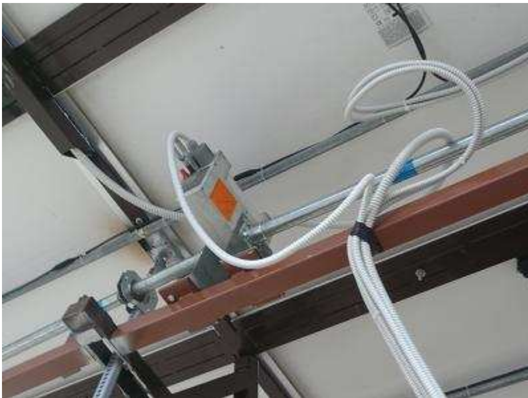
Figura 5.6.7 Sistema di movimentazione per la variazione dell'angolo di tilt
